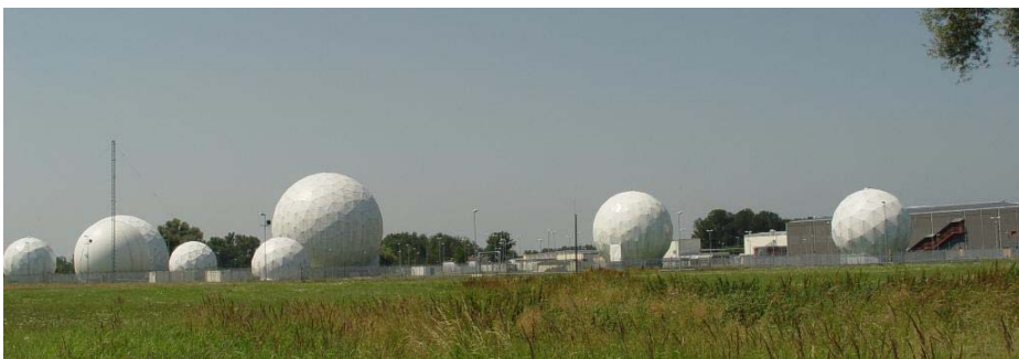
Abb. 3-2 Radarkuppeln der (inzwischen geschlossenen) Echelon-Station in Bad Aibling
